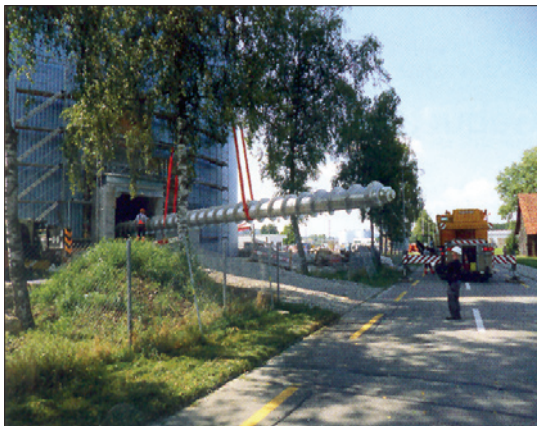
شکل ۲: هلیس تخلیه بهینه شکر ته سیلو
